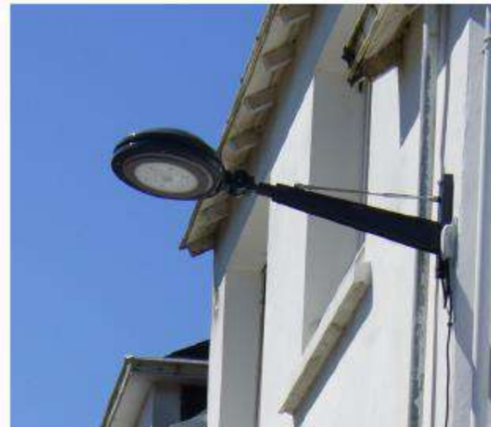
Les consoles façades
